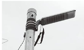
喬木村内の照明
