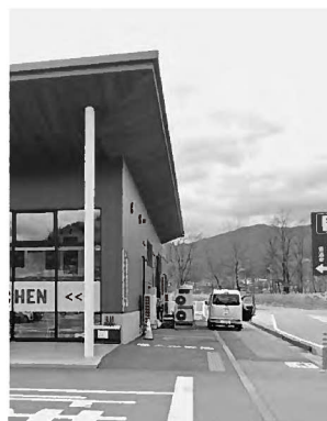
ベジフルキッチン北側に冷蔵庫を設置
