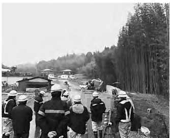
L型よう壁工事が進んでいる
