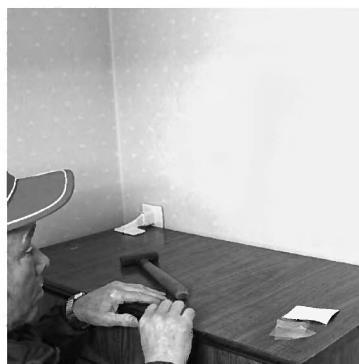
耐震ゲルマットを貼って、地震による家具の転倒防止対策
