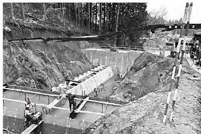
調整池の工事が進む現場
