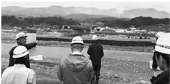
高森側の上部工が始まった竜神大橋
