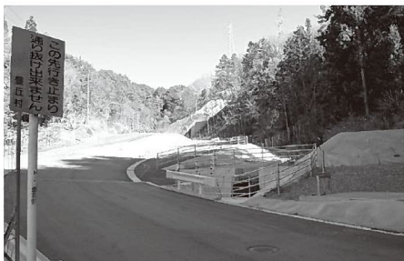
（佐原）下伊那変電所への道路
