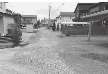
（田村）竜建ホミ一団地内道路
