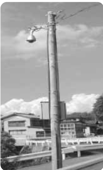
防災情報通信施設整備事業竣工 (芦部川監視カメラ)
