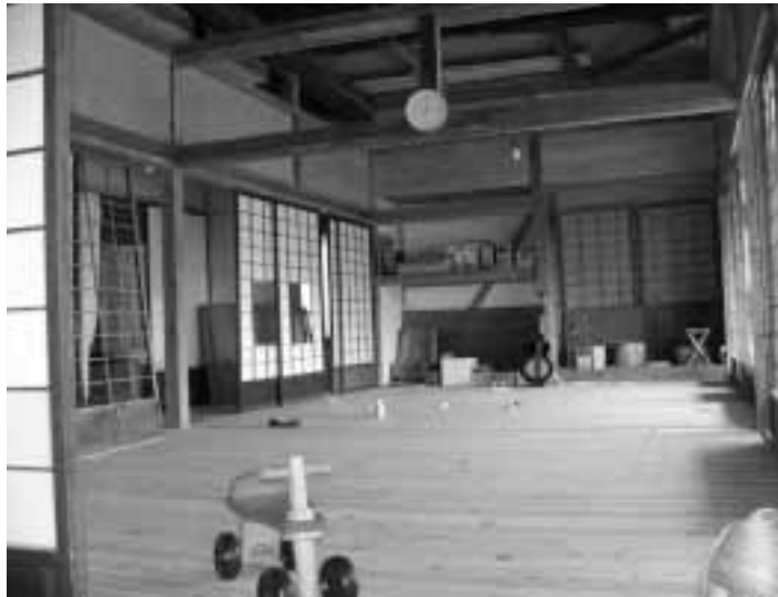
改修中の空家
