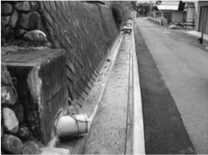
緊急経済対策での水路改修
