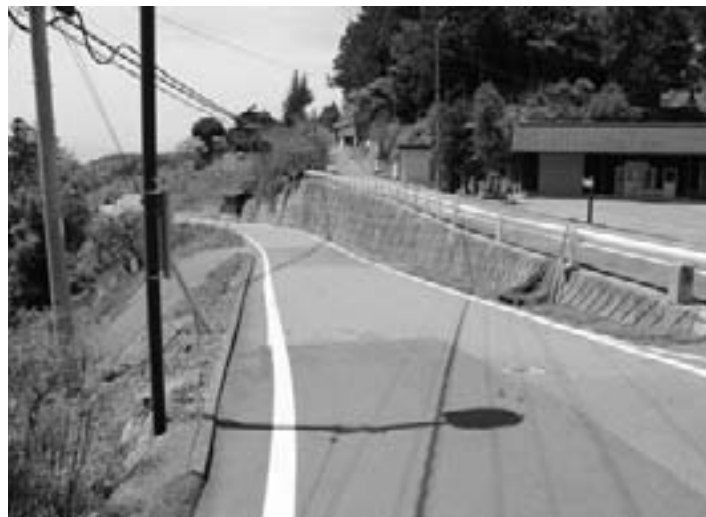
水道本管布設替えが予定されている堀越地区
