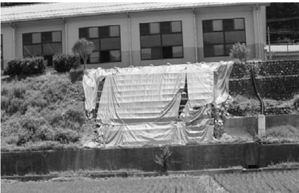
懸案の崩落防止工事予定地 (スポーツ館)
