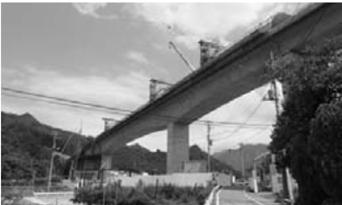
工事の進む山梨の実験線
