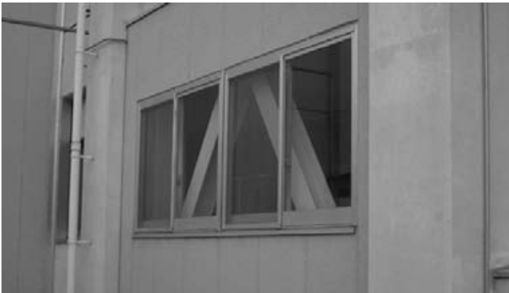
耐震改修された南小学校
