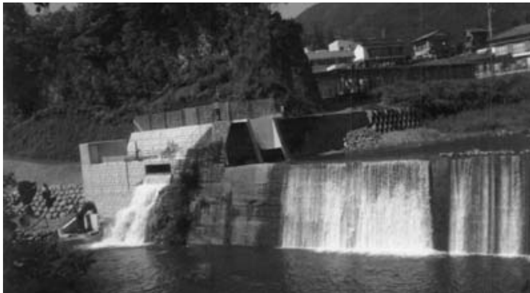
高知県梶原町の小水力発電所
