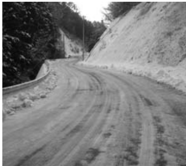
凍結して危険な長沢線
