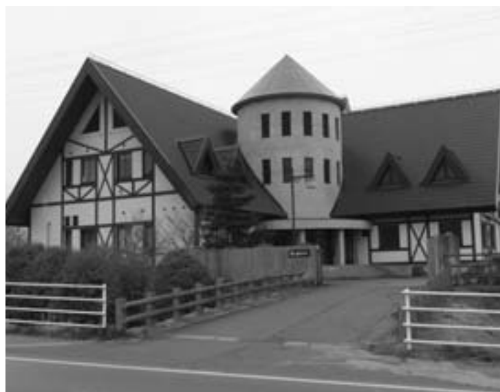
林里の浄化センター
