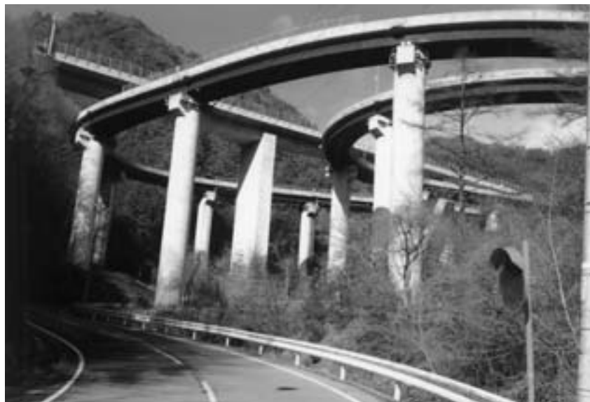
三遠南信道（矢筈公園付近）
