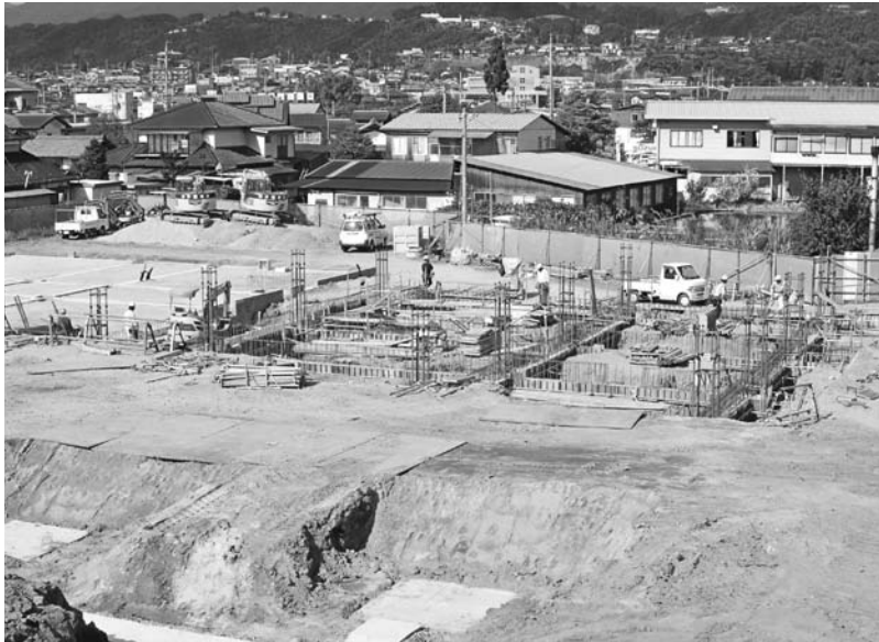
工事が始まった社会教育施設
