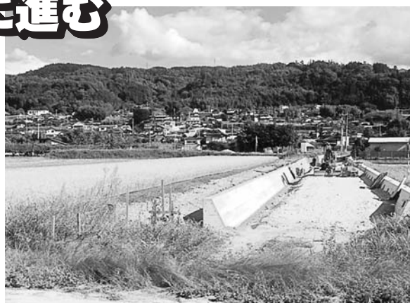
八王子 ミヤマブローラー跡地取り付け道路の新設進む
