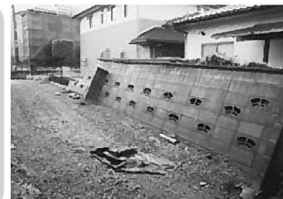
↑ 現行基準に適合せず転倒したブロック塀
