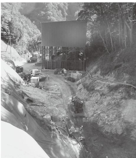
工事が進む戸中の残土置き場
