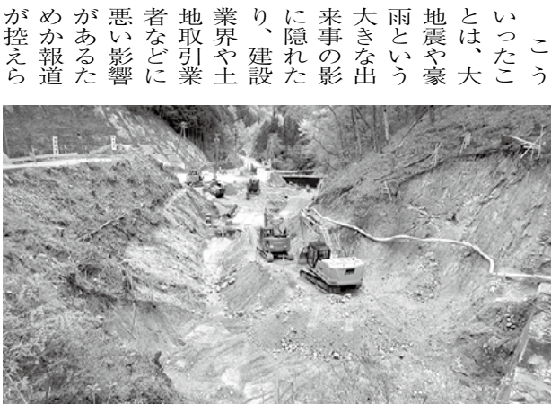
戸中下つ沢残土置き場工事
