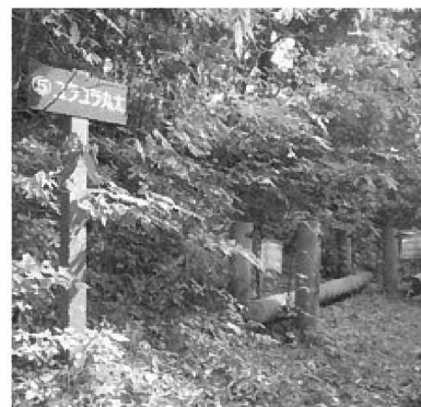
草に覆われ、老朽化したフィールドアスレチック
