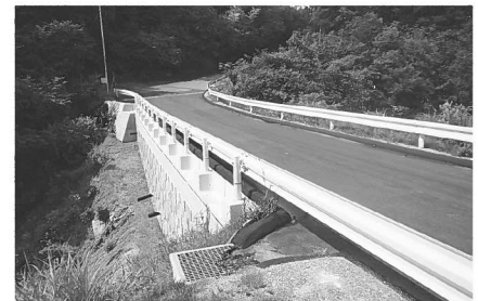
崩落した既設構造物も撤去され完成した福島線除地籍災害復旧
