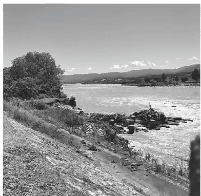
現在設置されている波消し（十字）ブロック
