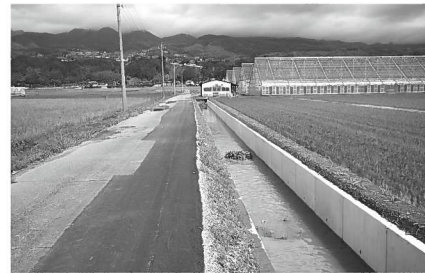
5月末には舗装復旧も完了した河野大淵排水路
