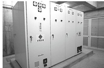
基盤の取り換えが行われる村民体育館受変電施設
