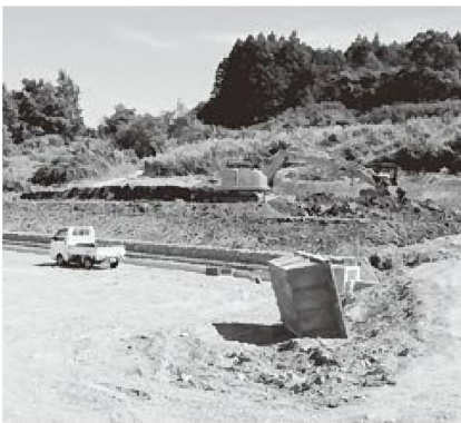
建設が進むクラインガルテン
