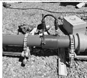
▲管の接合は 2 分間融着後 10 分間冷却。その間の振動は禁物。現場では酷暑の中、細心の注意が払われていました。
