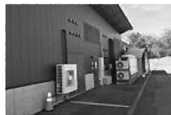
増設されたレストラン棟
