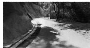
法面・側溝が整備された本谷線
