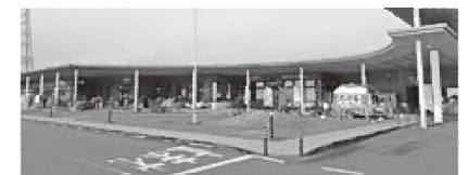
緑地化工事箇所
