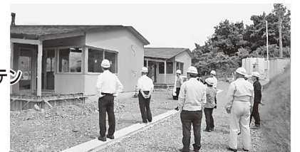
排水管敷設が完了 建物周りの仕上げが進む北エリア
