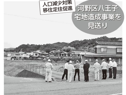
地盤改良工事で造成費の増加が見込まれる八王子地籍
