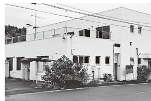
屋上出入口が設置される旧法務局
