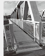
南小学校南の蛇川橋歩道
