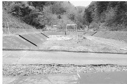
北の沢にある「豊丘村一般廃棄物の最終処分場」 平成16年4月より埋め立てごみの受け入れが開始
