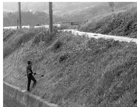
広大な村道法面も
