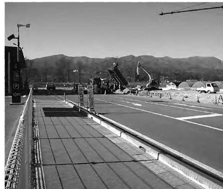
工事が始まった、豊丘マルシェ大型バス駐車場整備
