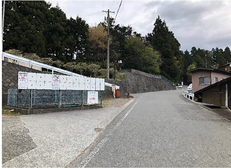
⑮本村貯水池フェンス
