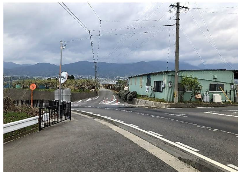
⑮-2佐原線なぎ上カーブ歩道フェンス
