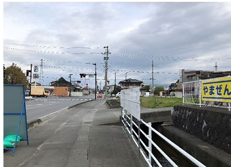
⑪やまぜん倉庫前一貫道路歩道ガードパイプ
