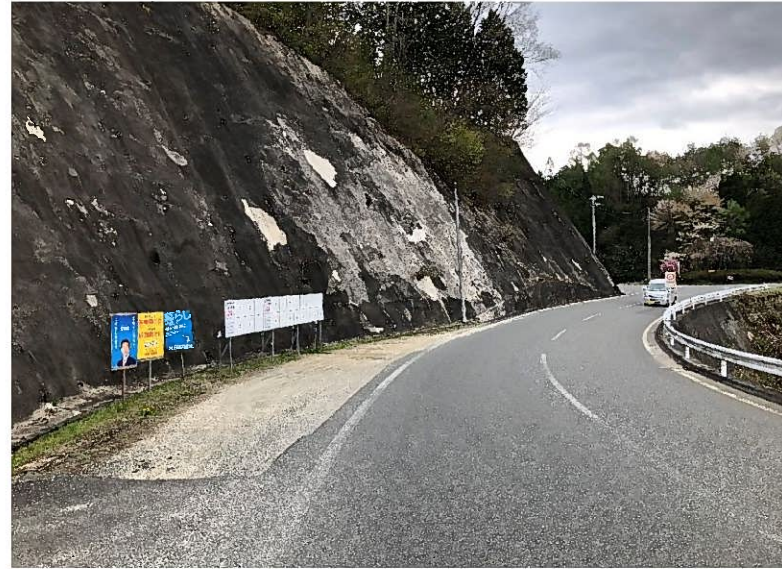
⑯壬生沢線、広域農道交差点付近道路残地
