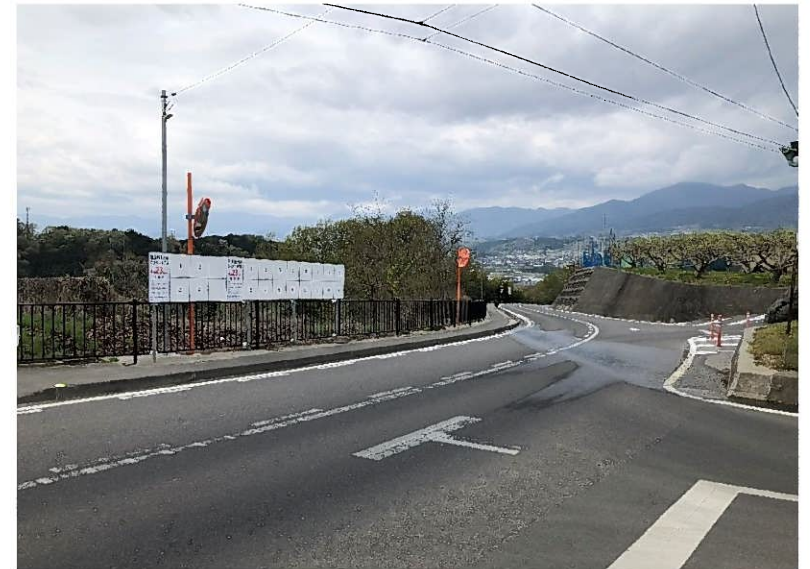
⑮-1佐原線なぎ上カーブ歩道フェンス
