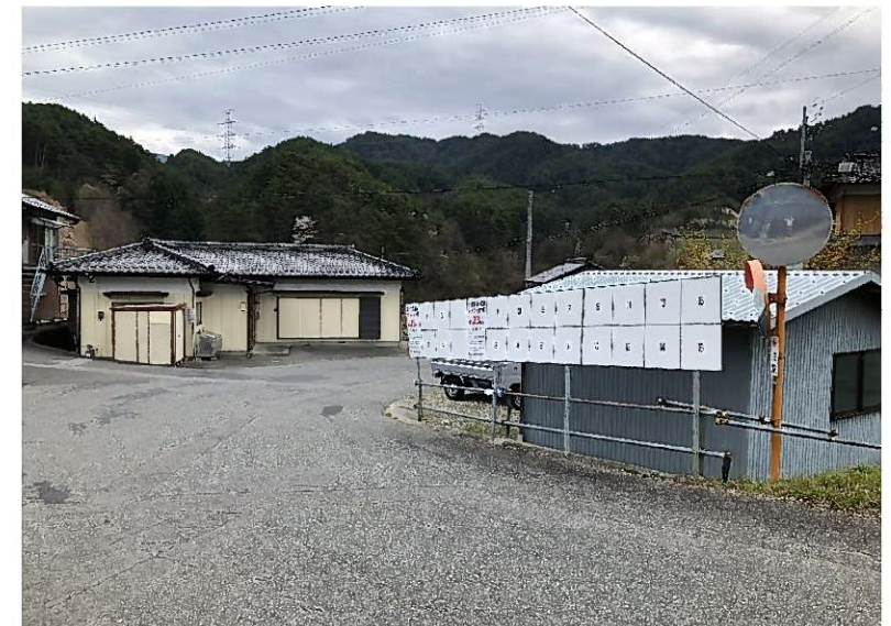
⑰長沢バス停前道路ガードパイプ
