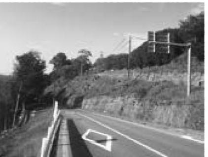
法面の掘削と整形を行い、高強度ネットを張るためのアンカーピンの打込みを行っています。
