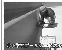
北小学校プールシート防水
