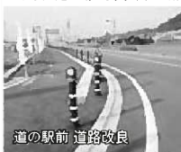
道の駅前 道路改良
