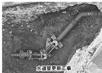
水道管更新工事
