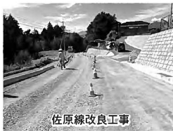
佐原線改良工事
