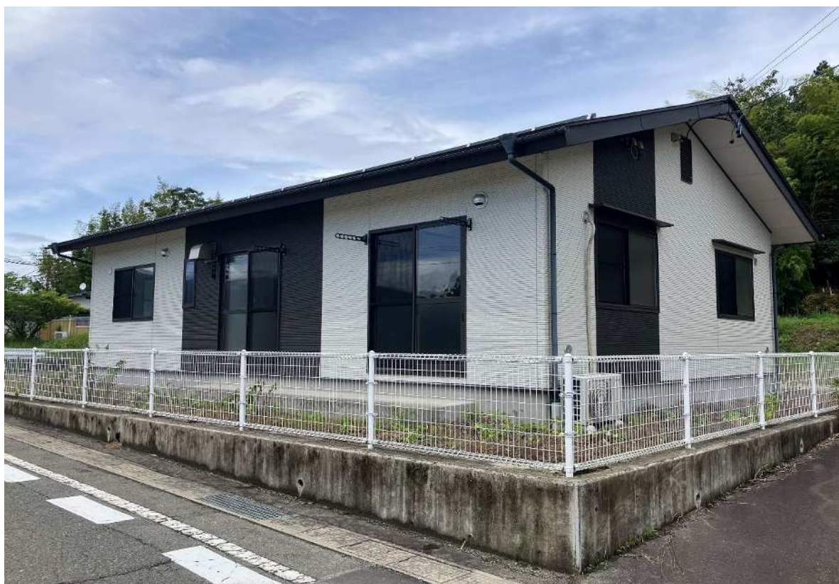
大柏団地 101 号棟の南西側
