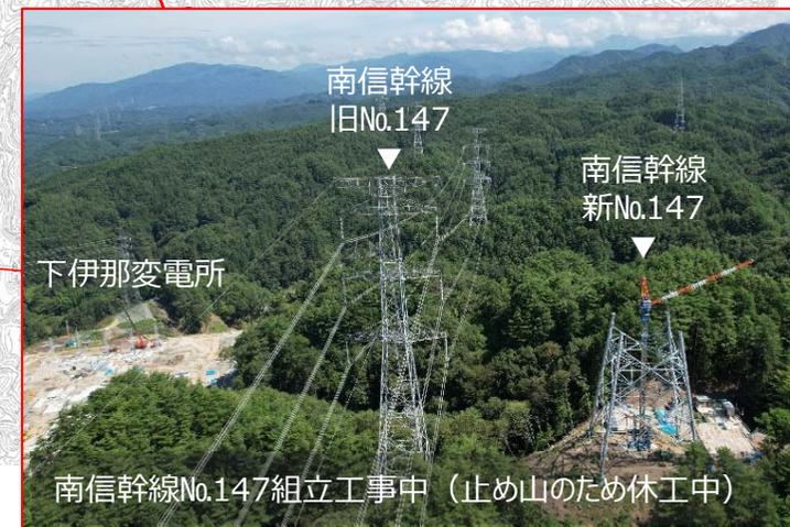
南信幹線No.147組立工事中 (止め山のため休工中)
