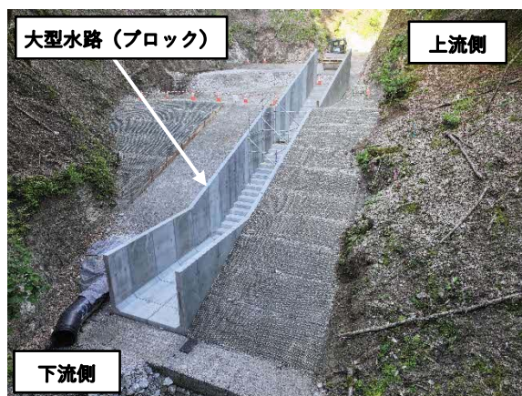
【発生土置き場(本山)】 調整池構築(大型水路工)
