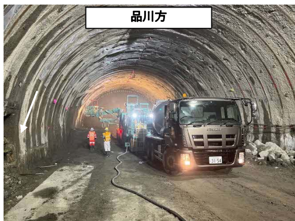
【トンネル工事】本坑掘削工
