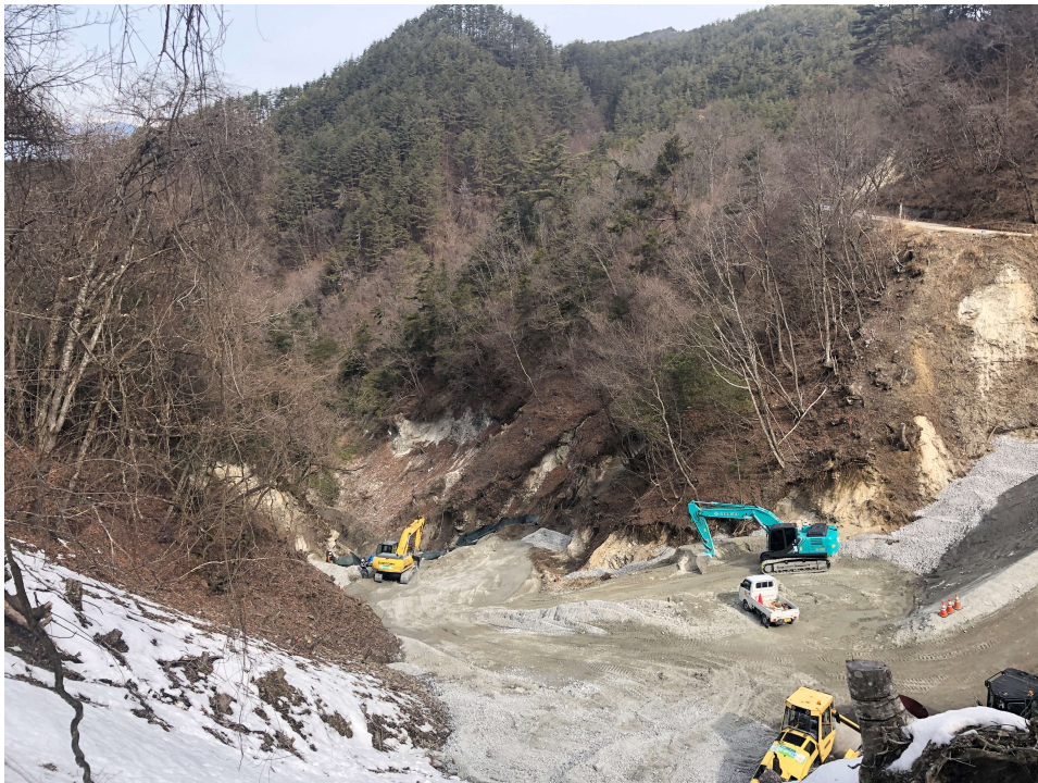
地下排水管の整備工事を行っています。 (中流部 林道側より撮影)
