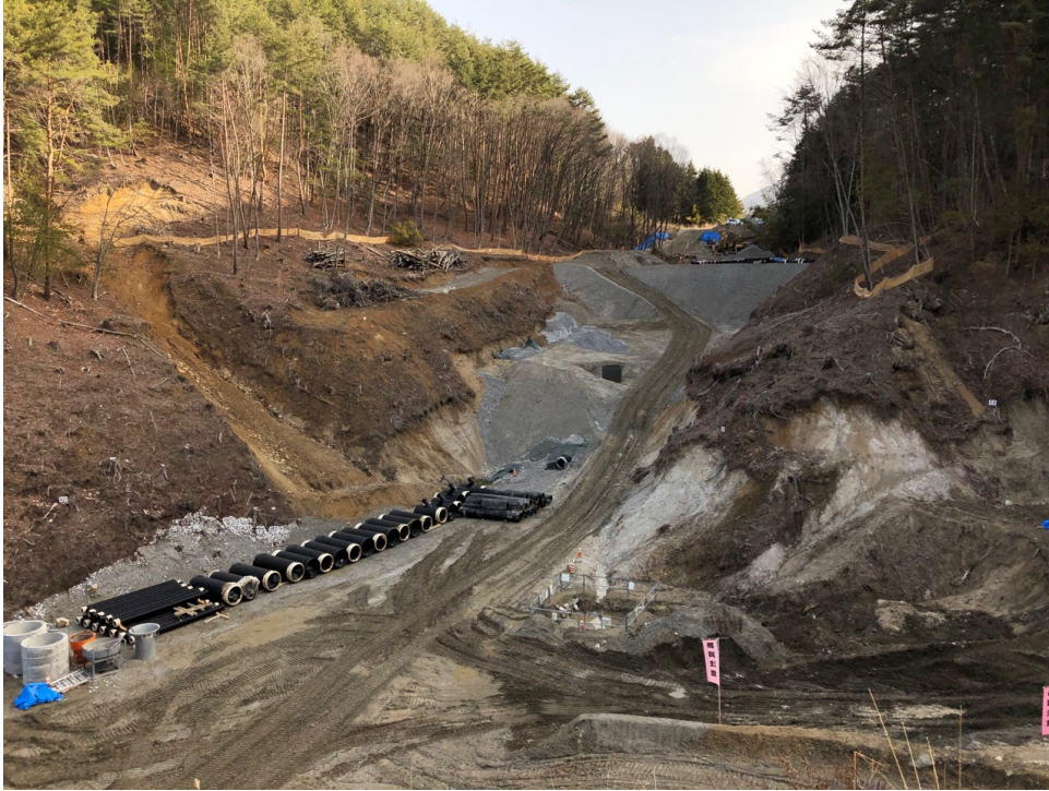
全景写真 (上流部 林道側より撮影)
