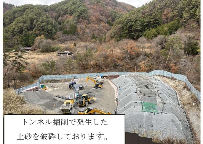
トンネル掘削で発生した土砂を破碎しております。
