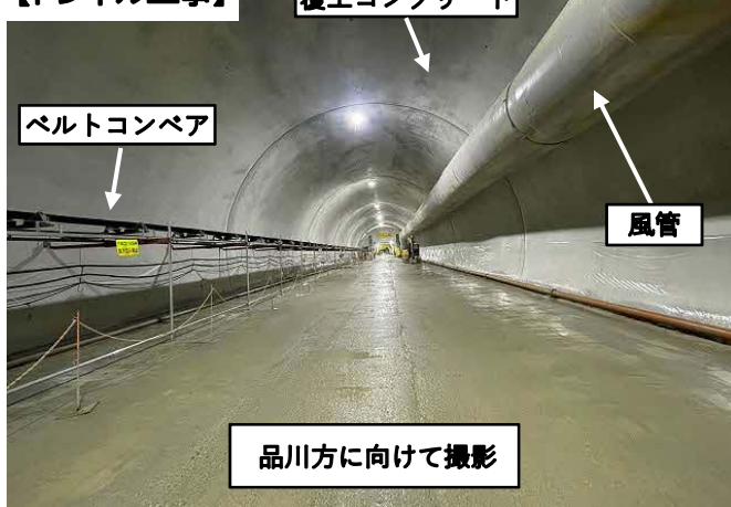
【トンネル工事】
