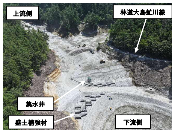
【発生土置き場(本山)】 盛土造成工
