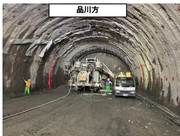
【トンネル工事】本坑掘削工
