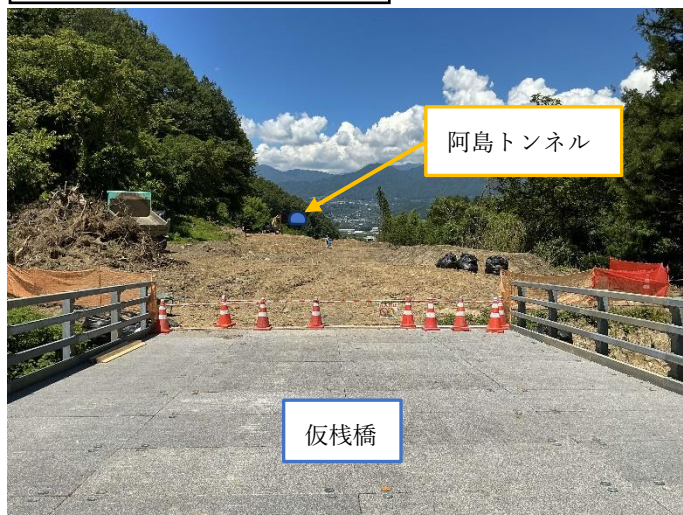
壬生沢川高架橋区間②
