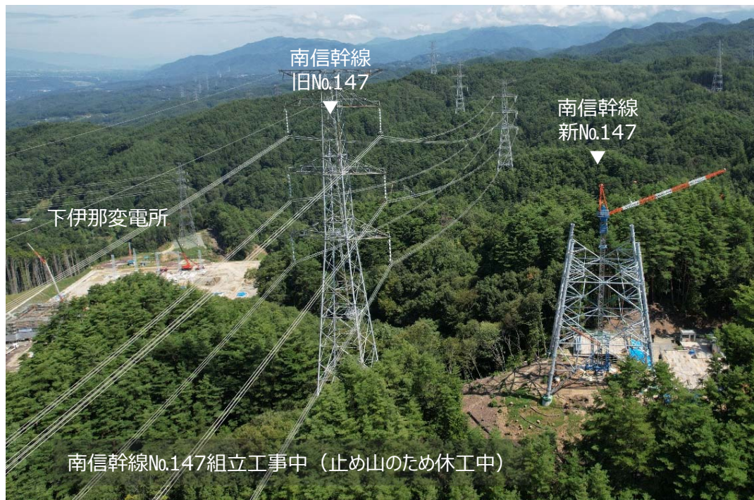
写真① 南信幹線No.147 組立工事（工事中）
