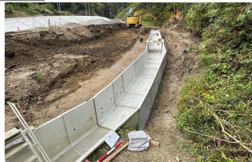
写真② 変電所下流水路構築状況 (水路部)
