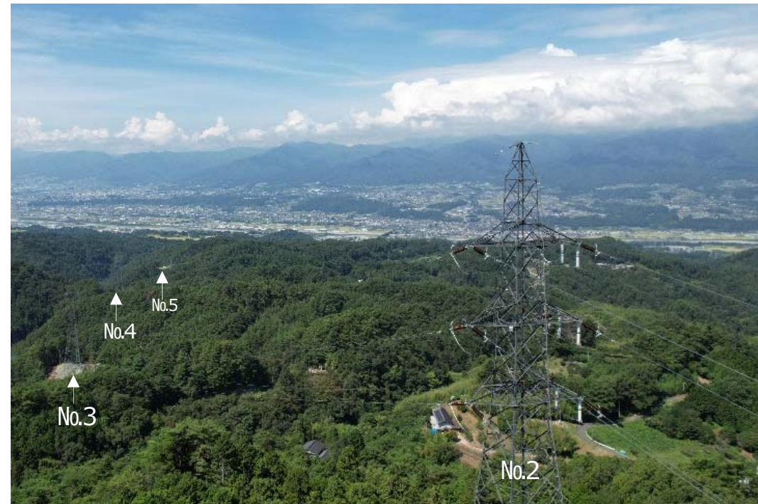
写真② 豊丘線No.1～6 架線工事（完了）
