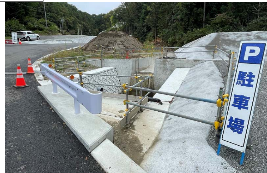
写真② 変電所下流水路構築状況 (水路部)
