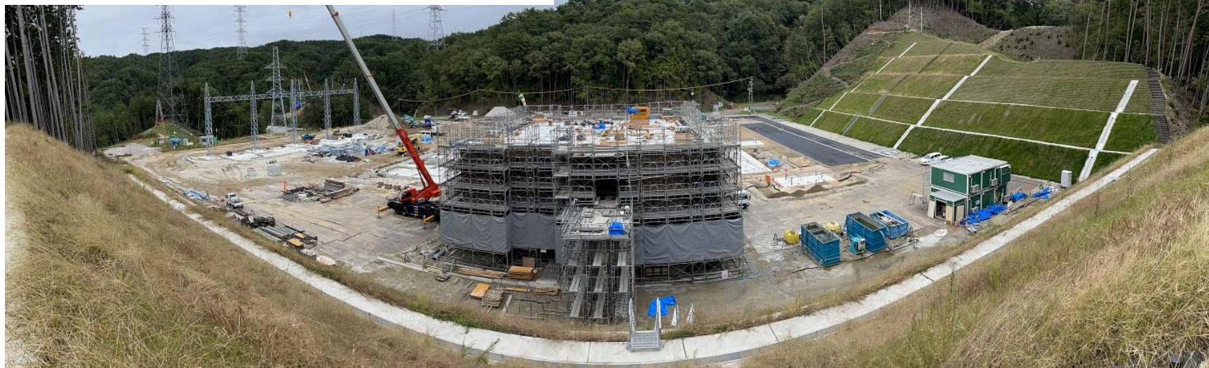
写真③ 変電所工事状況 (西側より)
