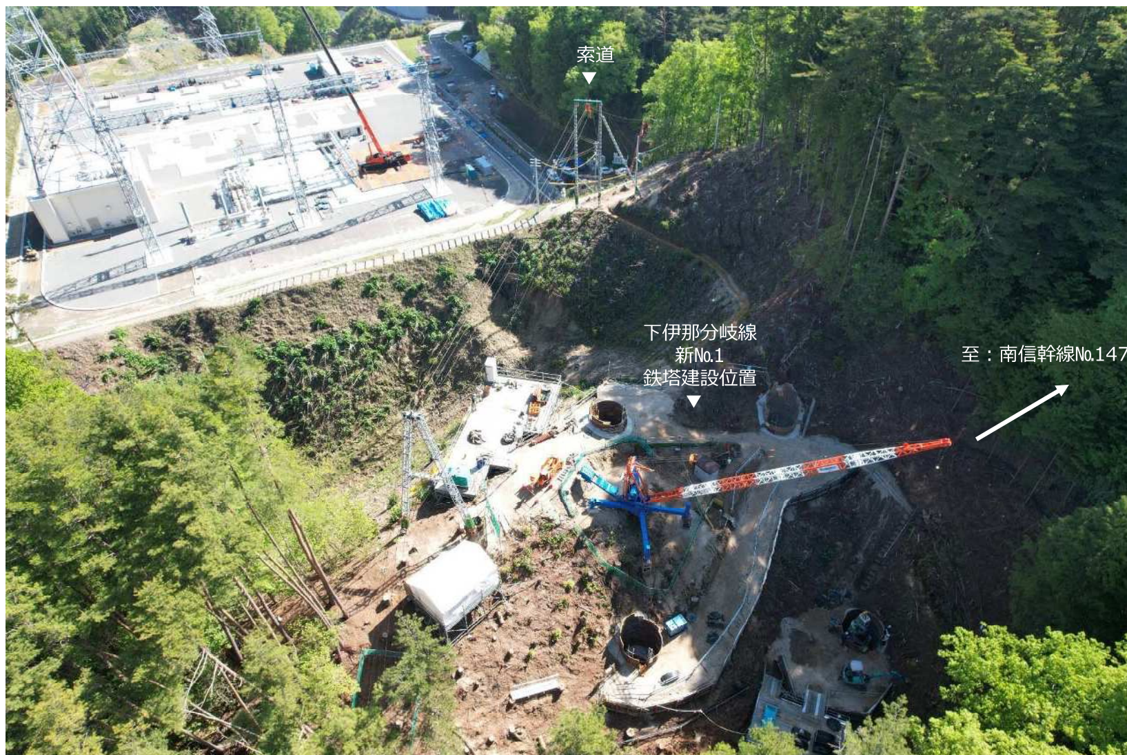
写真② 下伊那分岐線No.1 基礎工事（工事中）
