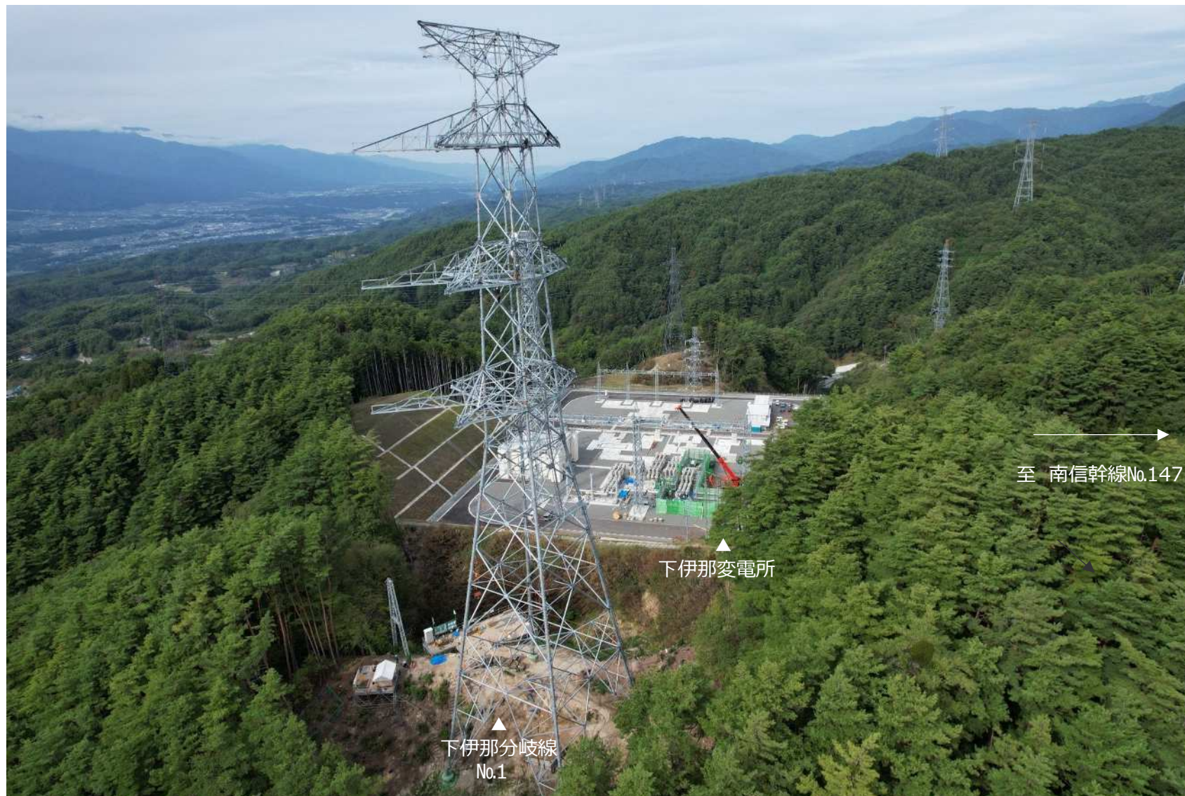
写真① 下伊那分岐線No.1 鉄塔組立工事（完了）
