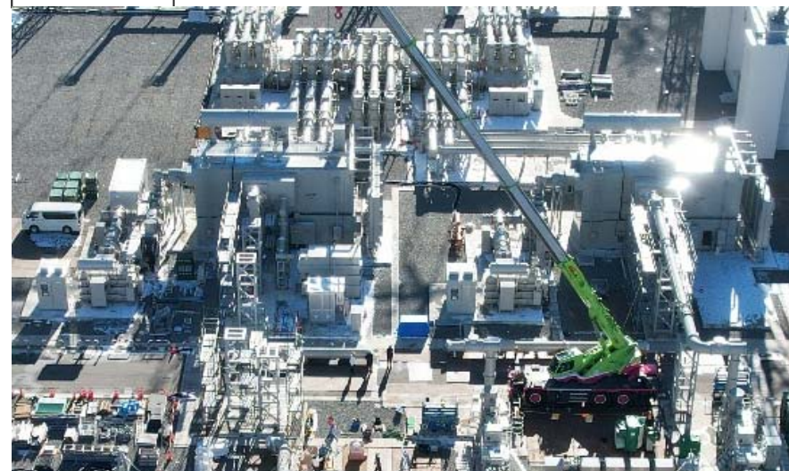
写真② 154 k V機器組立状況
