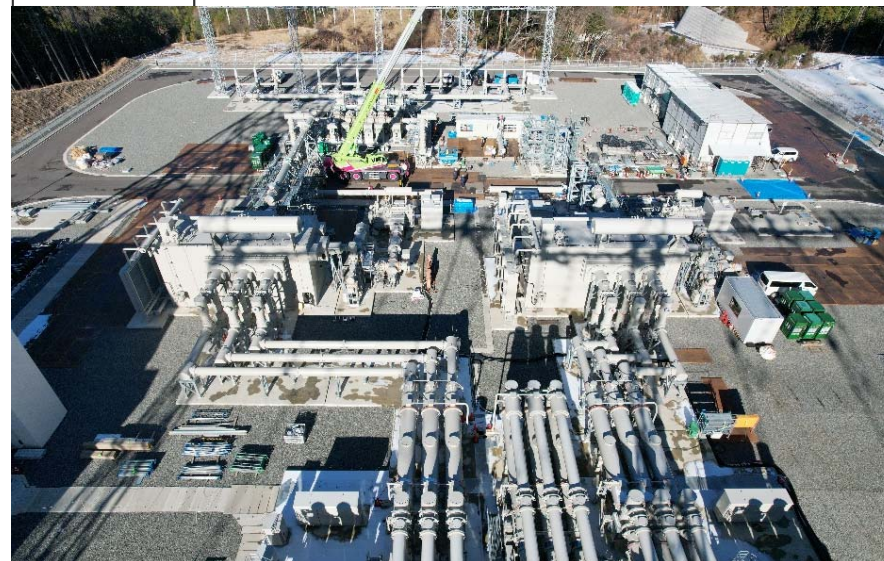
写真② 154 k V機器組立状況
