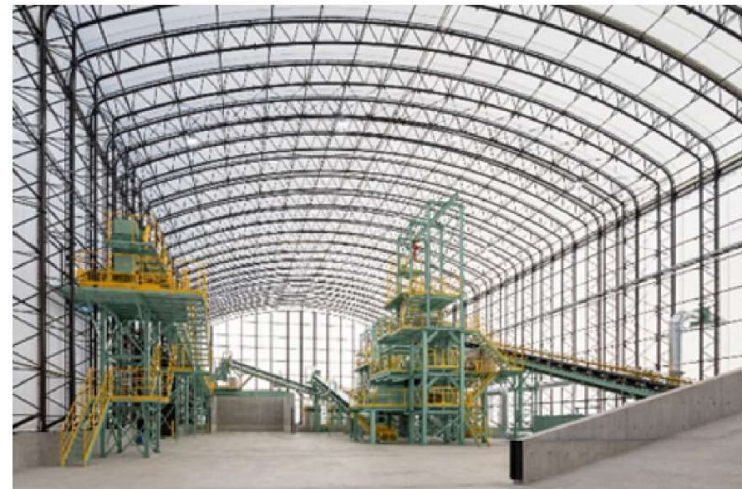
磁力選別処理設備
