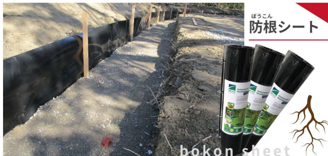
防根シート | 地中に埋め込んで物理的に根の侵入を食い止める
