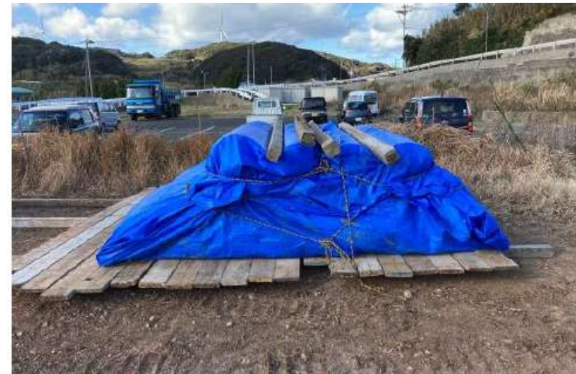
ベントナイトシートの荷下ろし時の状況(左)、ブルーシートによる養生(右)
