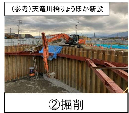
※一部の直接基礎については、①鋼矢板打込みを行わず、安定勾配にて②掘削を行う場合があります。
