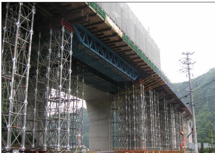
①支柱式支保工、②仮設梁設置
